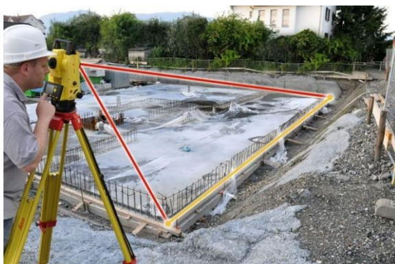
Figura 4. Replanteo con taquímetro y levantamiento As-built
